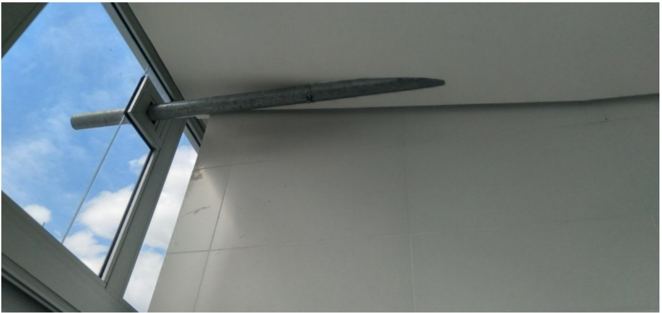
Foto XVI: Banheiros internos dos funcionários
