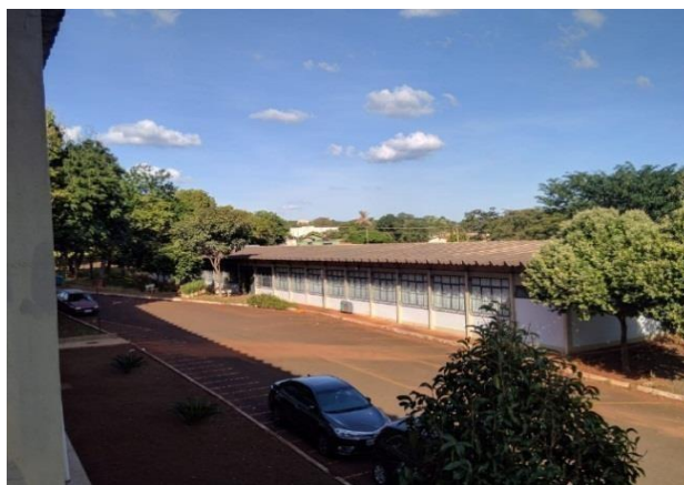
Foto 1. Bloco D - Salas de Aulas do curso de Tecnologia em Gestão do Agronegócio
