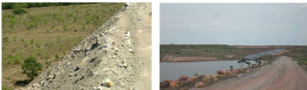
Figura 11 – Leiras sobre barramento: face externa e face interna. Fonte: Próprio Autor (2017).
